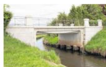
Im Jahr 1909 nach Plänen von Professor Max Möller erbaut: die Fischbauchbrücke.
